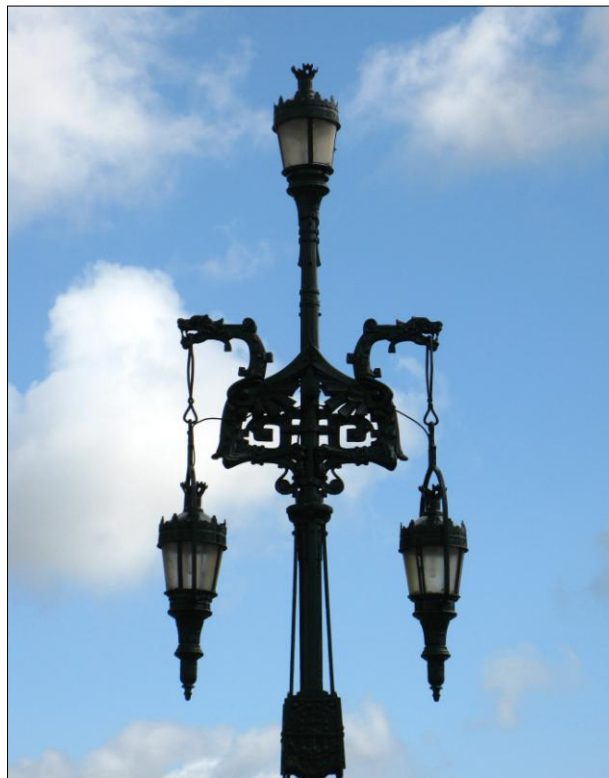
Farola . 1911. Fundición Wonenburguer. Técnica: Ferro fundido. Materiais: Pedra (base), ferro (base/poste de iluminación/farol), cristal (farol). Os farois orixinais eran esferas de cristal e ferro forxado. Cantón Claudino Pita/Rúa Porta da Vila, Betanzos. © Iria-Friné Rivera Vázquez.
